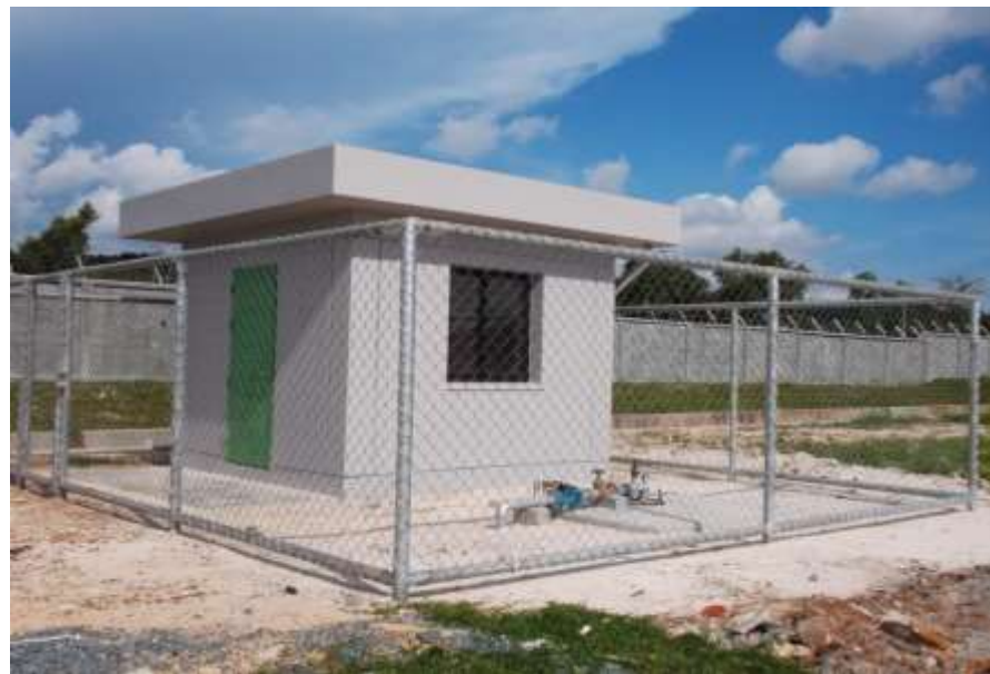
井戸ポンプハウス
