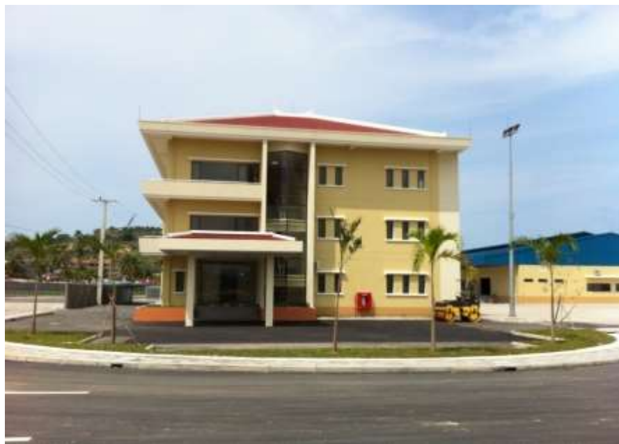
SEZセンター(管理事務所)建物
