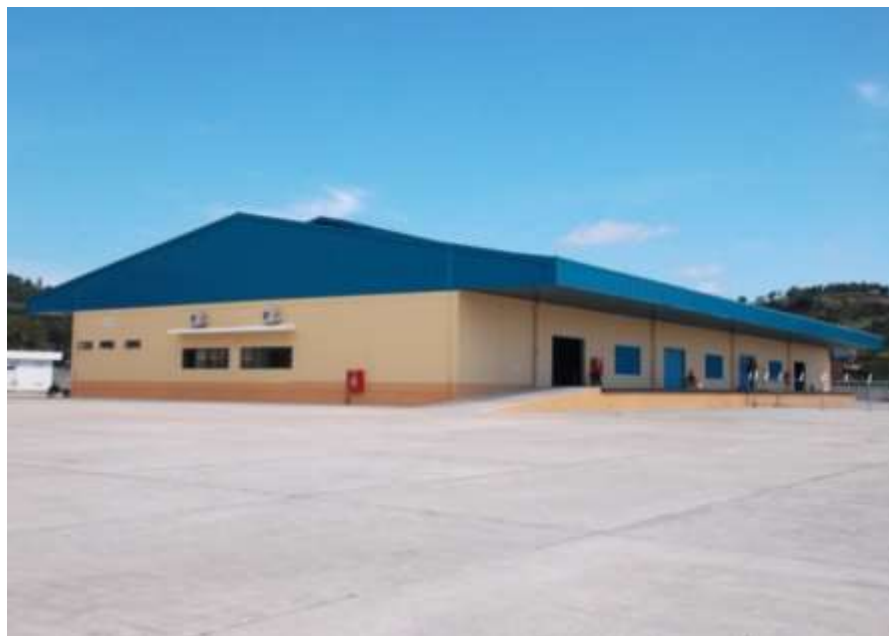
CFS倉庫 (小口コンテナ貨物集配)
